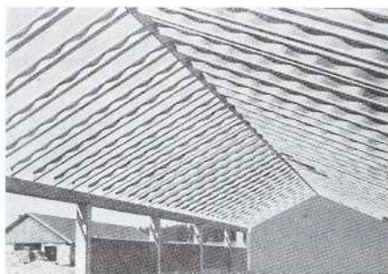
Bild 7: Wellstegträger, Entwickler: Hanns Hess, Grafrath 1957 (aus: „Deutscher Zimmermeister“, 20/1957)
