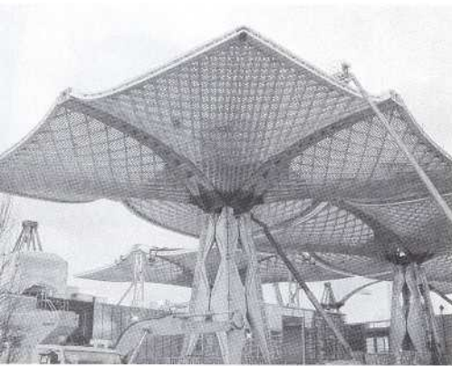
Bild 9: Expo-Dach Hannover. Zehn quadratische Schirme in Holz-Rippenbauweise überdecken 16.000 m 2 . (aus: „bauen mit holz“ 2/2000)
