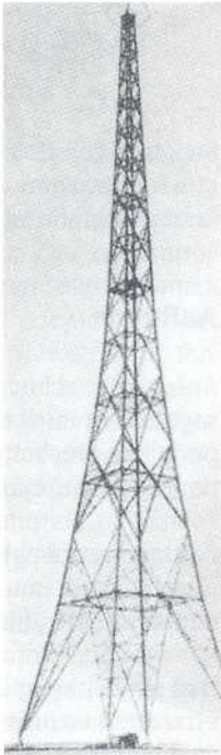
Bild 3: Funkturm in Mühllacker, 1933/34 von der Siemens Bauunion GmbH gebaut. Höhe: 190 m. Zerstört 1945. (aus: „bauen mit holz“ 8/1992)
