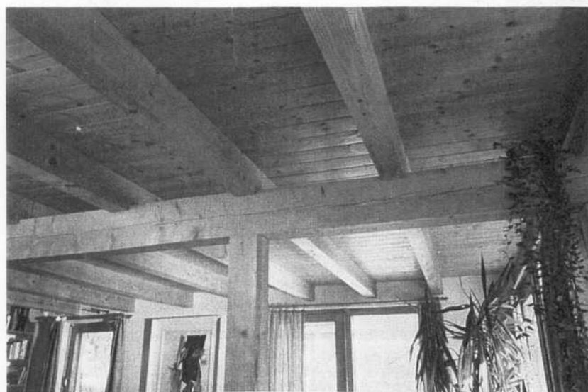
Bild 6. Holz-Beton-Verbund-Decke in einem Zweifamilienhaus in Igist/Schweiz, 1986 gebaut Fig. 6. Timber-concrete-compound floor in a two-families-house in Igist, Suisse, built in 1986
