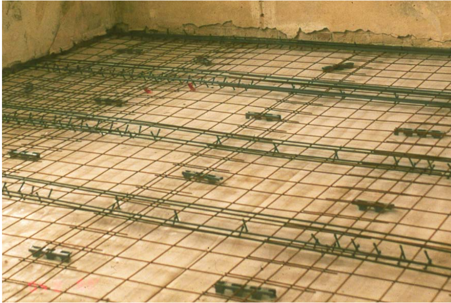
Bild 5: Ertüchtigung einer Altbaudecke wegen Umnutzung des Gebäudes
