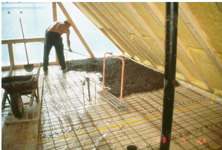
Bild 4: Betonieren einer HBV-Decke im Neubau
