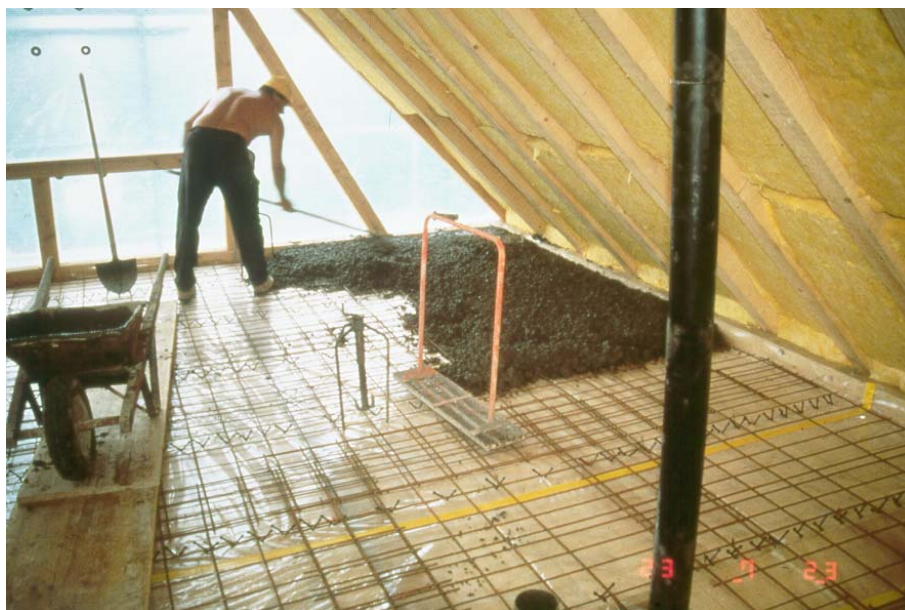
Bild 4: Betonieren einer HBV-Decke im Neubau
